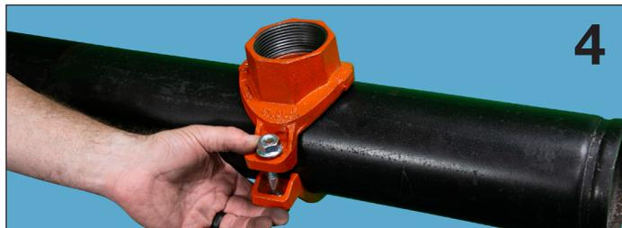
**4.** Inserte el perno en U (para 041) o alinee la carcasa de la Tee mecánica (MTT o MTG) con la carcasa de salida e instale las tuercas con los dedos para sujetar el conjunto de la T mecánica en su lugar sobre la tubería.
