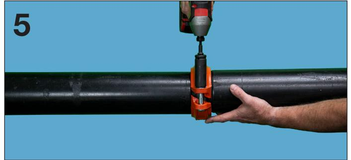
5. Apriete todas las tuercas en cantidades iguales mientras alterna entre todas las tuercas. Es importante apretar las tuercas de manera uniforme mientras se alterna el apriete de la tuerca para evitar que la junta se pellizque y asegurar un ajuste y sellado adecuados del conjunto de acoplamiento en tuberías y accesorios. Esto es necesario tanto para herramientas manuales como de impacto.
