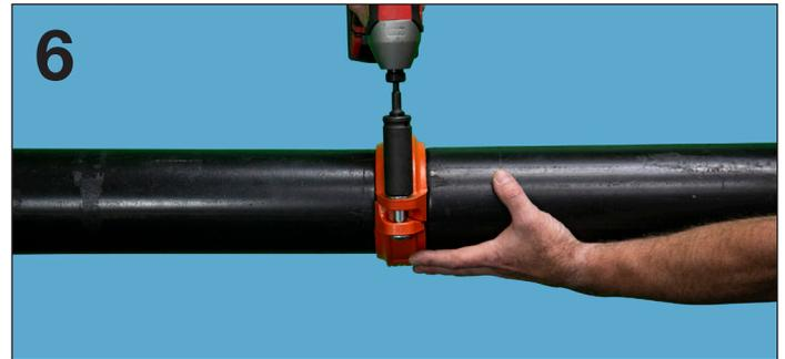
6. Deje de apretar las tuercas cuando se produzca un contacto de metal con metal entre las mitades superior e inferior del acoplamiento. El apriete excesivo de las tuercas a mano o con herramientas de impacto más allá de los límites de torsión especificados en la Tabla A para un tamaño de perno determinado puede dañar el acoplamiento y provocar fugas.
