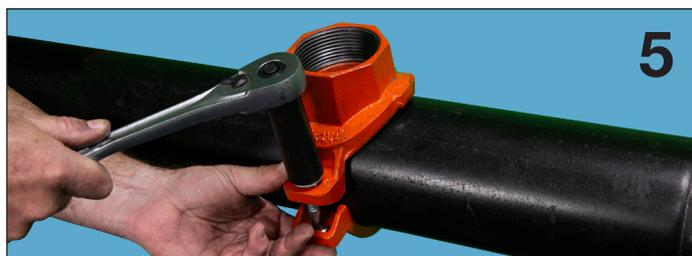
**5.** Apriete todas las tuercas en cantidades iguales mientras alterna entre todas las tuercas. Es importante apretar las tuercas de manera uniforme mientras se alterna el apriete de la tuerca para evitar que la junta se pelizque y asegurar un ajuste y sellado adecuados del ensamblaje en Tee mecánico sobre las tuberías. Esto es necesario tanto para herramientas manuales como de impacto.
