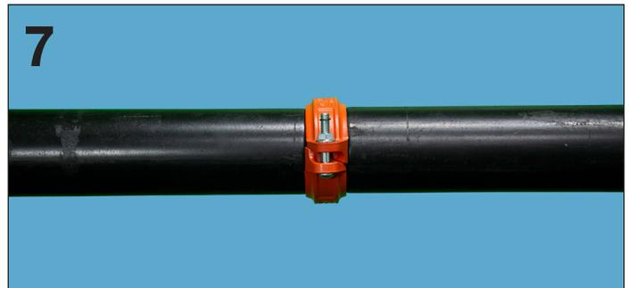
7. Inspeccione visualmente los pernos en cada lado del acoplamiento para asegurarse de que se logre un contacto de metal con metal y que además sea consistente. También inspeccione para asegurarse de que la lengüeta de las mitades del acoplamiento esté completamente colocadas en las ranuras de la tubería.
